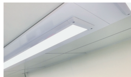
3. 照明器を設置します
