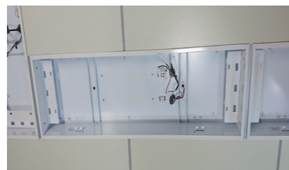
1. 蛍光管、ソケット、安定器を取り外します
